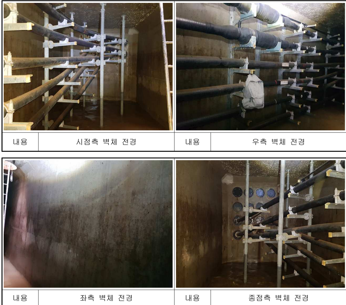
【사진 5.9】 수색 #By Pass 전경
