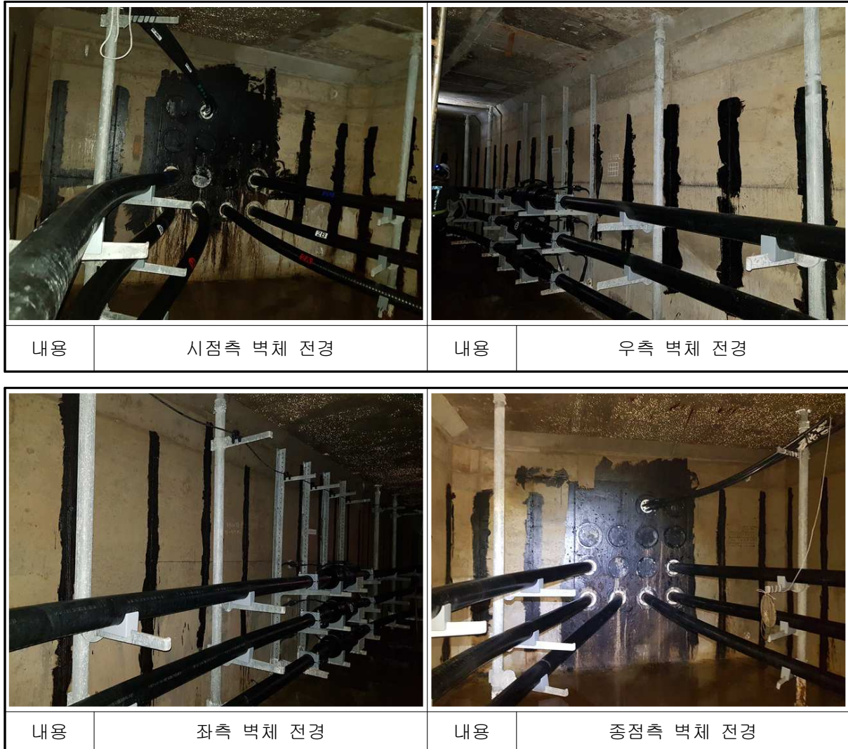
【사진 5.17】 원형 #2 전경
