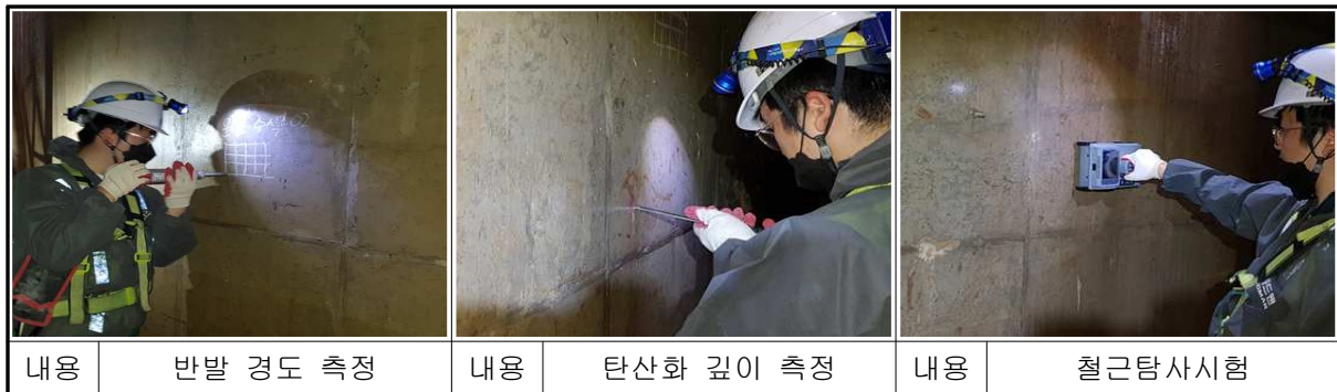
【사진 5.21】 원흥수색 재료시험 전경
